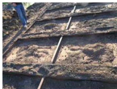
Chapas superiores cubiertas de tierra
