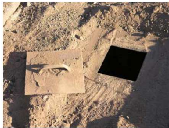
Orificio de chapas superiores con tapadera
