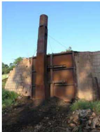
Puerta cerrada con aberturas inferiores
