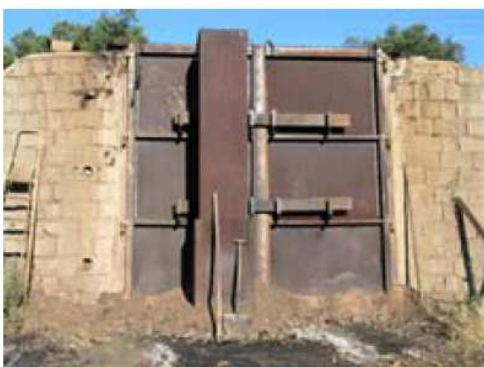
Puerta principal cerrada completamente
