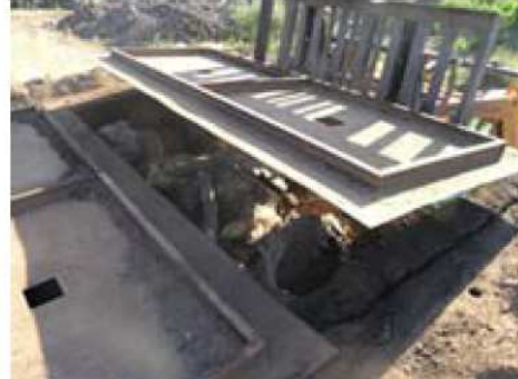
Colocación de chapas con pala cargadora
